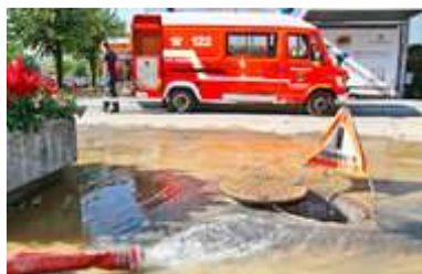
Wasserleitung geplatzt: Sturzflut in Klagenfurt
